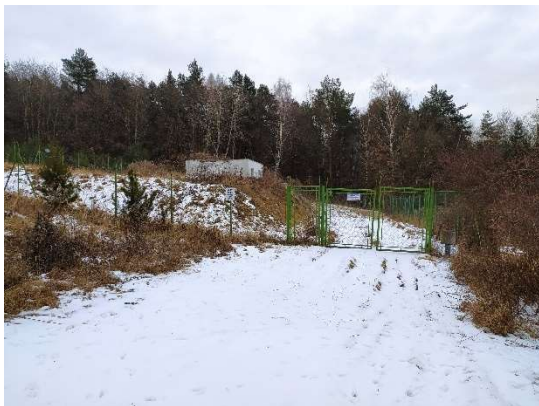
Obr. č.23 vodojem VZO-9
