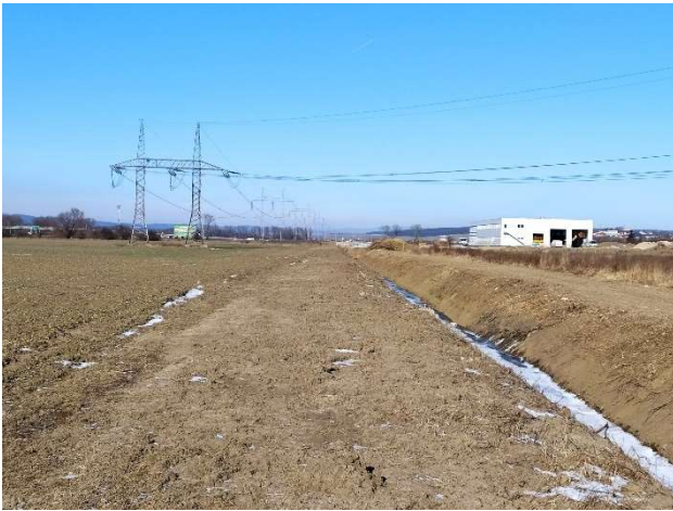
Obr. č.22 Odvodňovacie zariadenie OZ-2/1 po jeho prečistení
